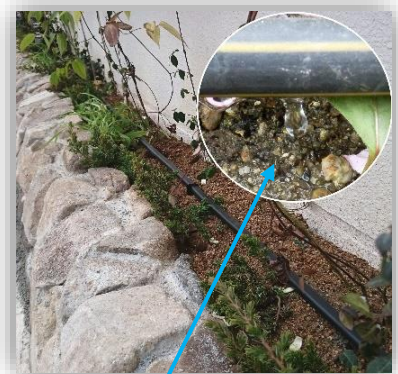
灌水ホース(30cm 間隔の穴から均一に水がしみだす)
